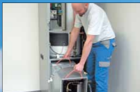
Nasunutí chladicího boxu do tepelného čerpadla
