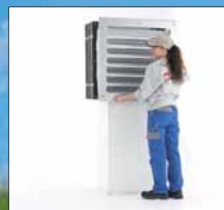
Ještě jej upevnit k tepelnému čerpadlu a propojit s obvodovou zdí.
